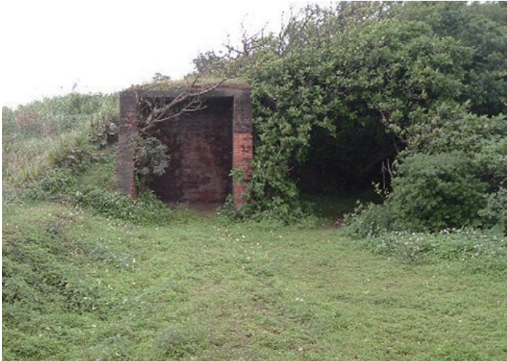
社寮東砲台探照燈收納庫與軌道
